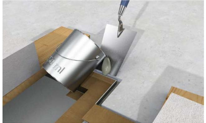
Zur Verfüllung der Fugen/Randzonen empfehlen wir schwindarmen Vergussbeton oder eine Epoxidfüllung. Aushärtezeit der Vergussmasse beachten!
